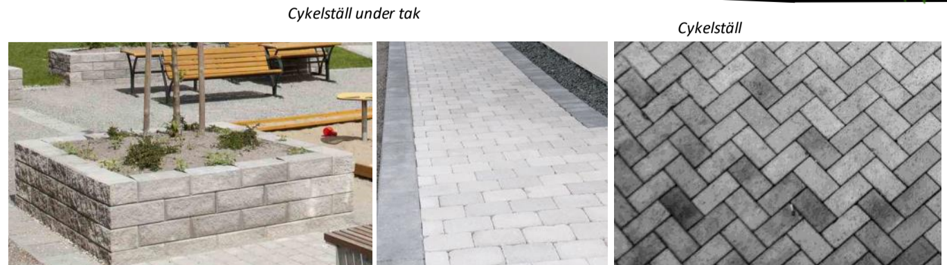
Planteringslådor byggda av murblock i grå betong En mörkare marksten markerar gångar & portar Marksten lagd i fiskbensmönster ger rums känsla till sittplatserna
